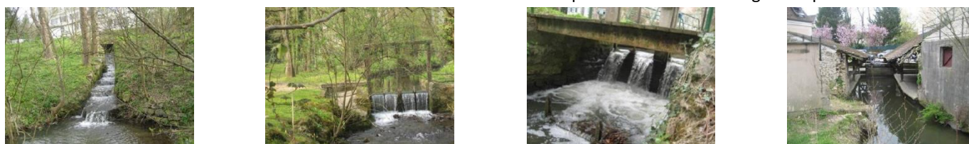
Figure 1: Quatre des ouvrages concernés par les travaux de restauration de la continuité
