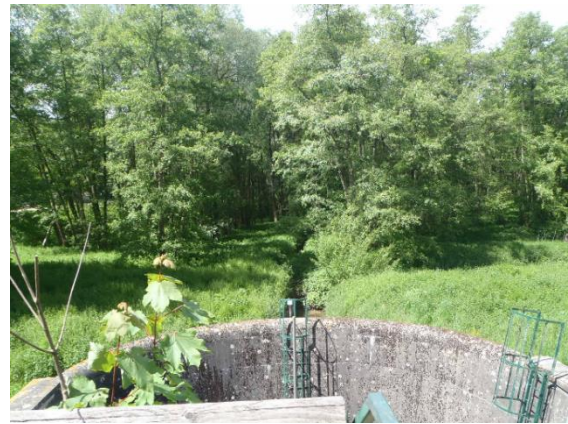
Figure 2: Vue avant travaux vers l'amont de l'ancien déversoir du bassin de la Mérantaise et du canal béton
