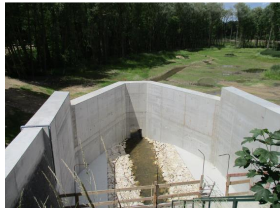
Figure 3: Vue après travaux vers l'amont du nouveau déversoir du bassin de la Mérantaise
