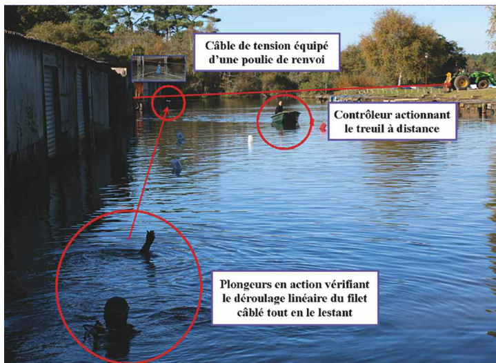
Description des modalités pour la pose des écrans.
