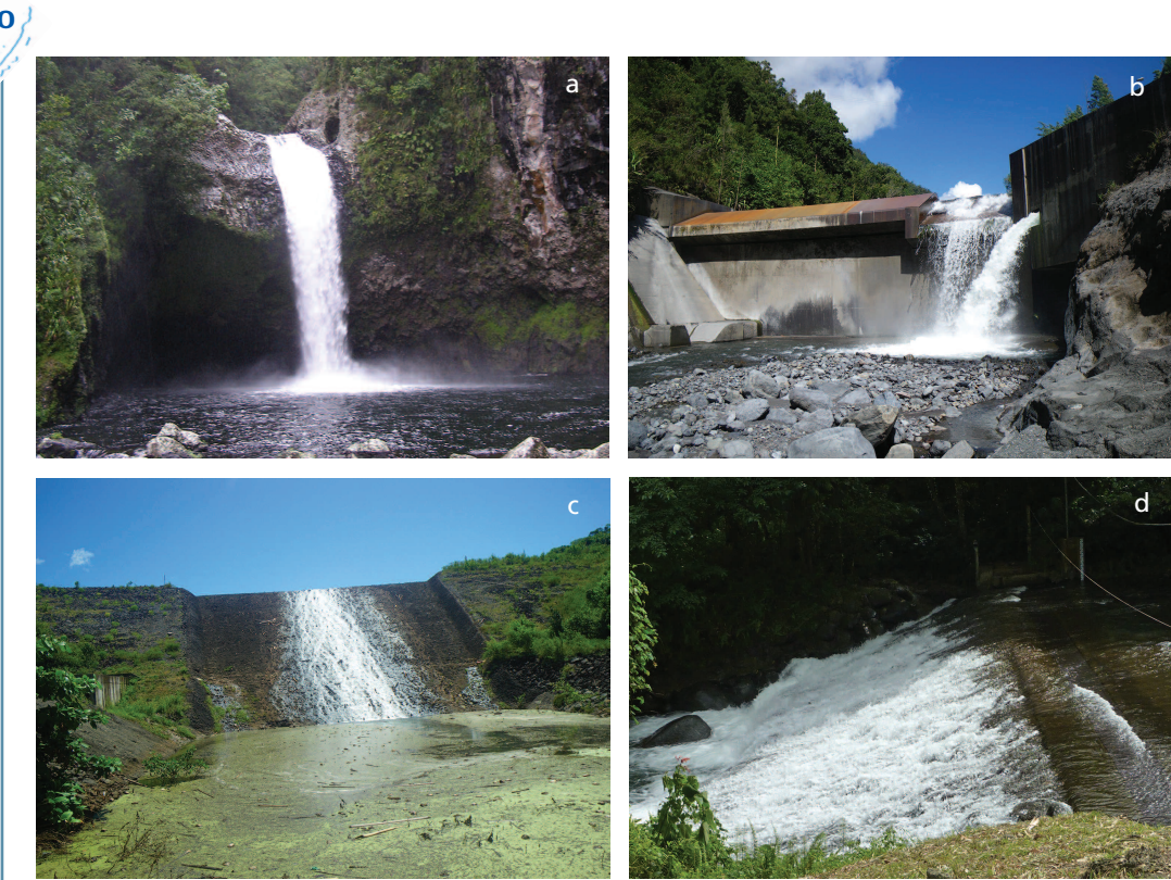
Exemples de passages à franchir au niveau de déversoirs ou de chutes naturelles. (a) Chute naturelle (La Réunion), (b) Chute verticale sur déversoir de barrage (La Réunion), (c) Déversement sur coursier de barrage (Mayotte), (d) Déversement sur coursier (Martinique).
