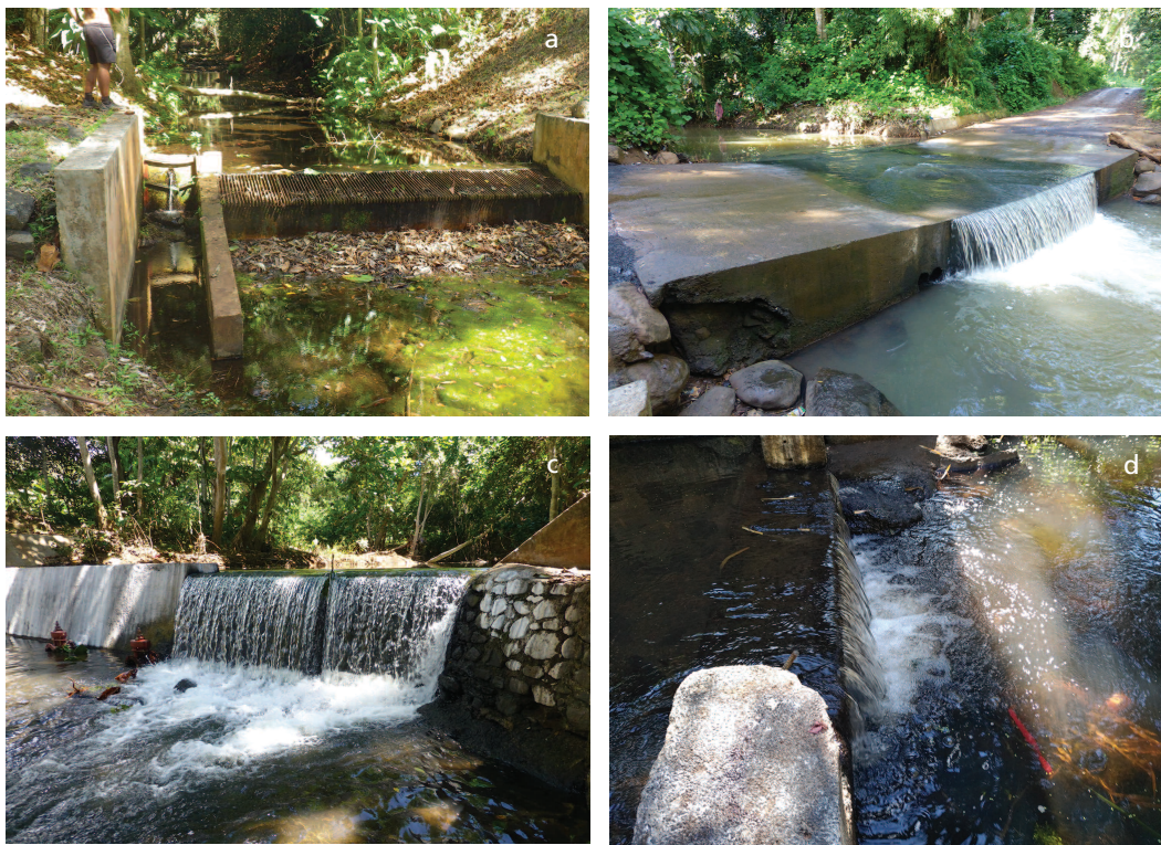
Exemples de fosses en aval d'ouvrages. (a) Fosse insuffisante, (b) Fosse suffisante, (c) Fosse insuffisante, (d) Fosse suffisante.
