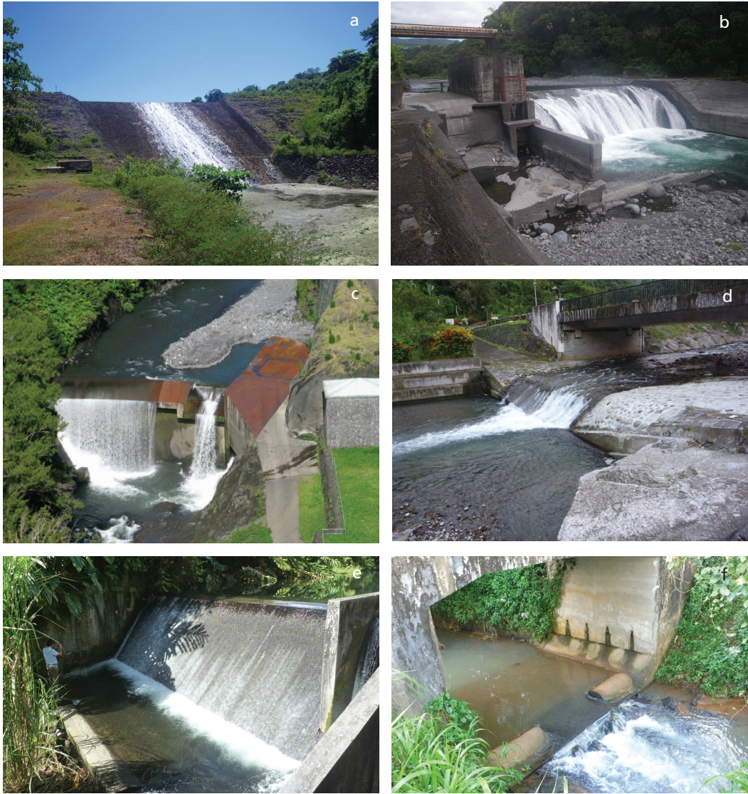
Exemples de seuils ou barrages présents sur les cours d'eau des départements insulaires ultramarins. (a) Retenue AEP de Dzoumogné (Mayotte), (b) Seuil d'irrigation de Bengalis sur la rivière du Mât (La Réunion), (c) Seuil de prise ILO de la rivière du Mât (La Réunion), (d) Seuil de stabilisation sur la Grande Rivière (Martinique), (e) Seuil de prise EDF sur la rivière Bananier (Guadeloupe), (f) Seuil hydrométrique (Martinique).
