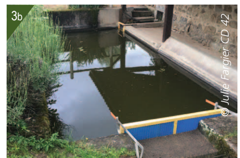
2 - a, b et c. Localisation de la population de crassule sur l'étang en 2014 (en rouge). 3 - a et b. Filtres installés au niveau du fossé (a) et du lavoir (b).
