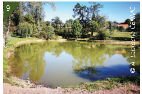
7 - Andain des terres extraites. 8 - Plan d'eau à sec. 9 - Étang après travaux.
