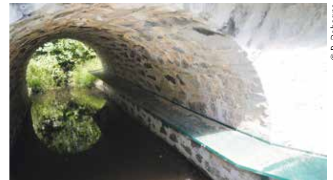
▲ Aménagement sur le site Natura 2000 de la Vallée de la Creuse et affluents.
