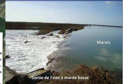
Rupture de la digue : deux brèches de 25 et 10 ml
