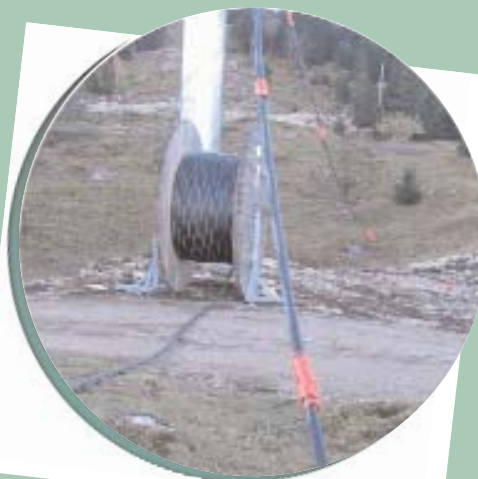
Manchons anti-collision pour oiseaux sur câbles des remontées mécaniques
