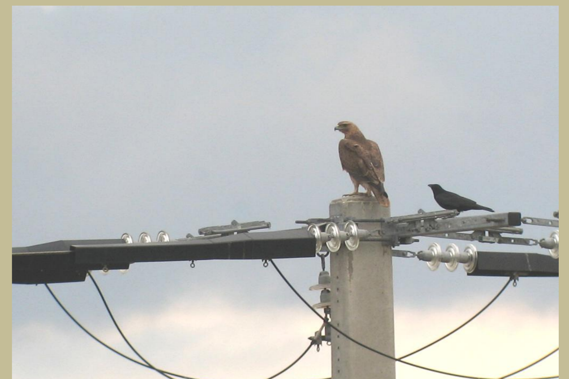
Photo 1 : Jeune Aigle de Bonelli posé sur un pylône neutralisé en plaine de la Crau. Les gaines en plastique noire évitent aux oiseaux de faire contact entre deux fils au décollage ou atterrissage. © N. Vincent-Martin CEN-PACA
