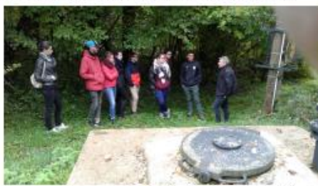
Captage des sources de Moulins (Bouxières-aux-Chênes)
