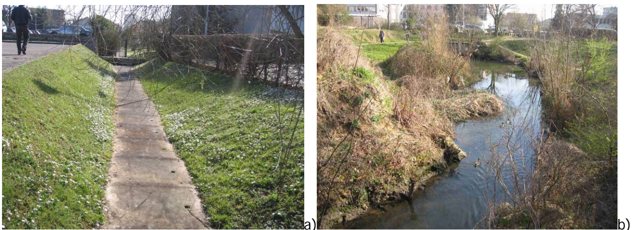
Figure 7 : Exemples de réalisation de niveau R2 la Bièvre à Antony a) dans sa partie couverte) et b) immédiatement en aval, dans une partie remise à ciel ouvert (photos Malavoi)
