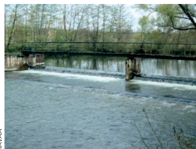
L'ouvrage de Roussy amont avant les travaux, en 2013. À l'origine, le clapet basculant était en position haute provoquant une chute d'eau supérieure à un mètre.
