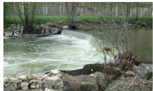
L'ouvrage de Roussy aval avant les travaux en 2013.
