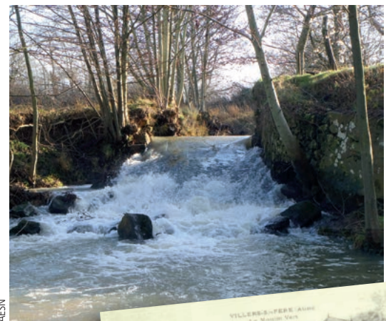
Le seuil du moulin Vert, avant les travaux d'effacement
