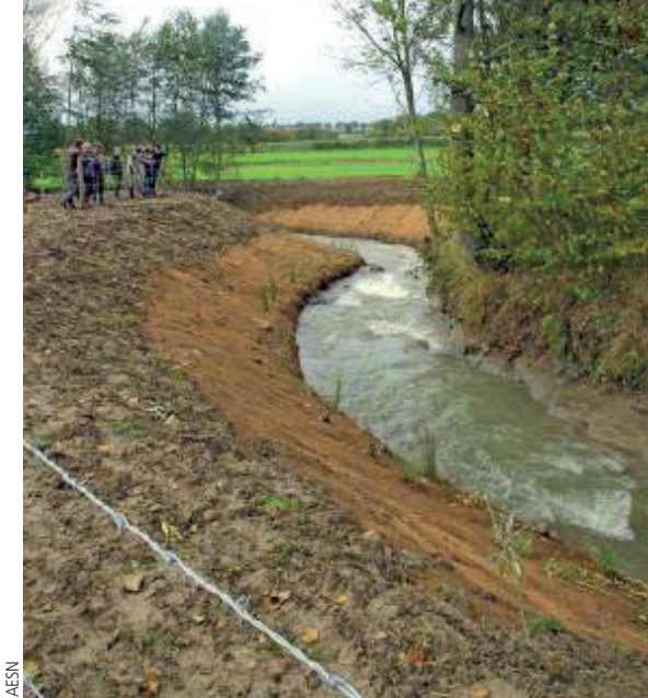
Le site de Moulin Vert après travaux, vue de l'amont en novembre 2013.
