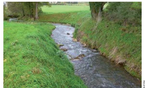
Le site du moulin Canard après travaux, vue de l'amont en novembre 2014.
