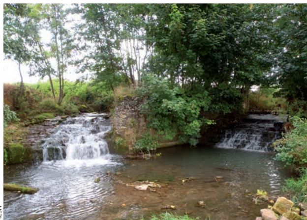
Le seuil du moulin Canard, avant les travaux d'effacement
