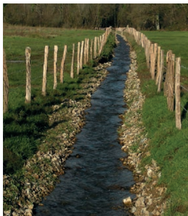
Le fond de vallée après travaux en décembre 2012
