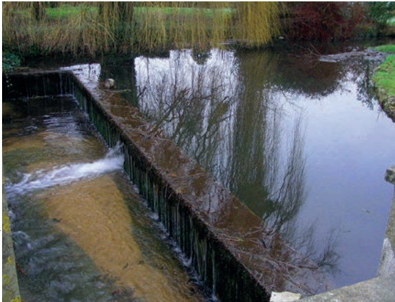
La Coignardière lors de la vidange hivernale de la réserve incendie préparatoire aux travaux en janvier 2012
