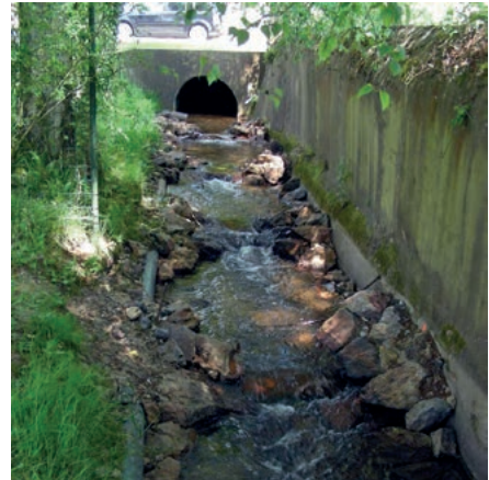
Pré-barrages aménagés à l'aval du pont routier après dérasement du seuil en 2013
