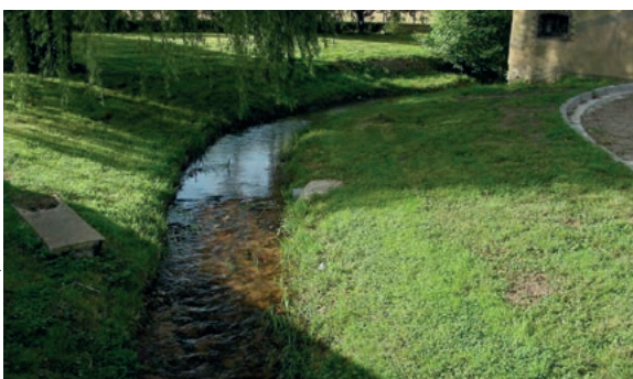
Le lit et les berges de la Coignardière quatre ans après travaux en 2016
