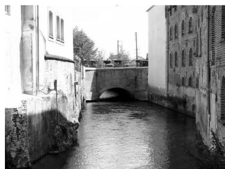
*La Canche, après les travaux de restauration. Arasement du seuil, démolition du garage et curage des sédiments fins sous le pont*
