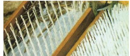
Pour les civelles, les écartements retenus sont de 7 mm entre faisceaux de soies tandis que pour les anguillettes et anguilles, l'écartement est de 14 mm.
