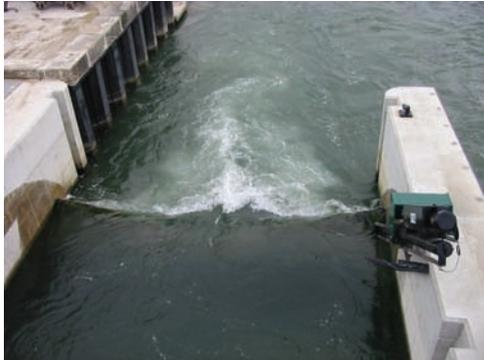
Photographie 27 : Vanne de régulation passe à poissons barrage Jaulnes (77) – rivière Seine (GEI/SIEE)
