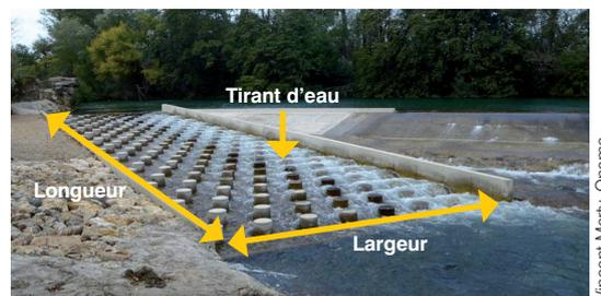
Figure 40 – Mesures à effectuer sur une rampe à singularités régulièrement réparties.
