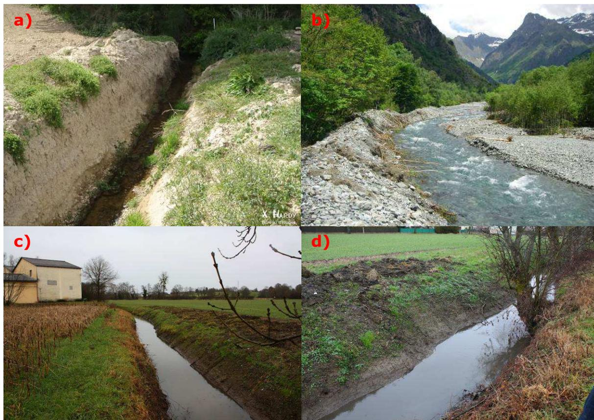
**Figure 9 : Exemples des types d'informations de curage. a) tas de curage et traces d'engins, b) merlon de curage nu, c) merlon de curage nu et traces d'engins et d) tas de curage et traces d'engins.**
