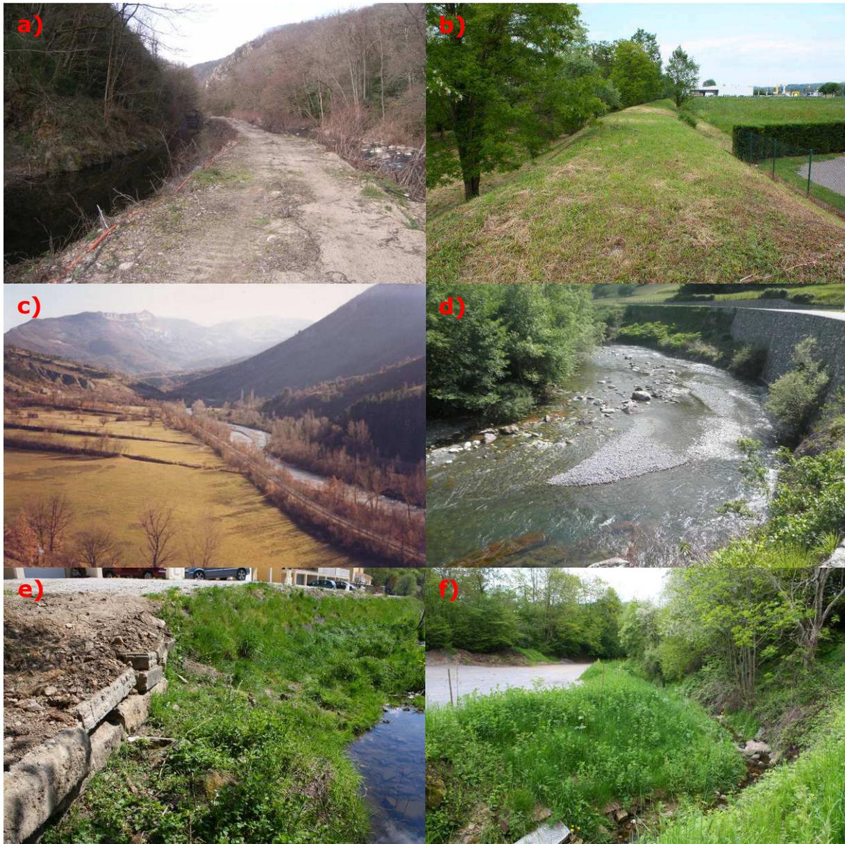
**Figure 10 : Exemples de digues. a) digue en remblai simple, b) digue en remblai façonnée, c) digue soutènement de voie ferrée et digues perpendiculaires au cours d'eau, d) digue en béton, e) et f) lit majeur remblayé.**
