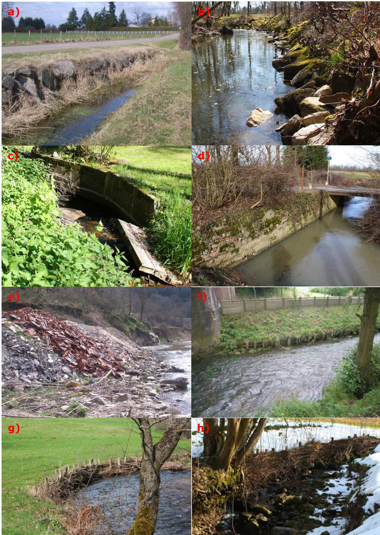
**Figure 13 : Exemples de protections de berges. a) enrochements, b) enrochements en partie écroulés, c) et d) mur en béton, e) matériaux agglomérés, f) tunage, g) et h) tressage**
