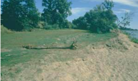
L'annexe hydraulique du Gros Ormeau (Indre-et-Loire) avant travaux de reconexion. Août 1999
