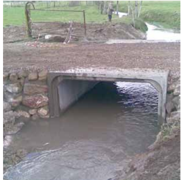
Installation du pont cadre à la place de la buse sur le site de Chaussoy. Printemps 2008
