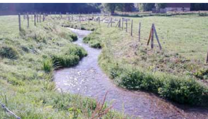
Restoration du gabarit naturel et de la sinuosité de la Trie, 4 mois après travaux. Été 2008
